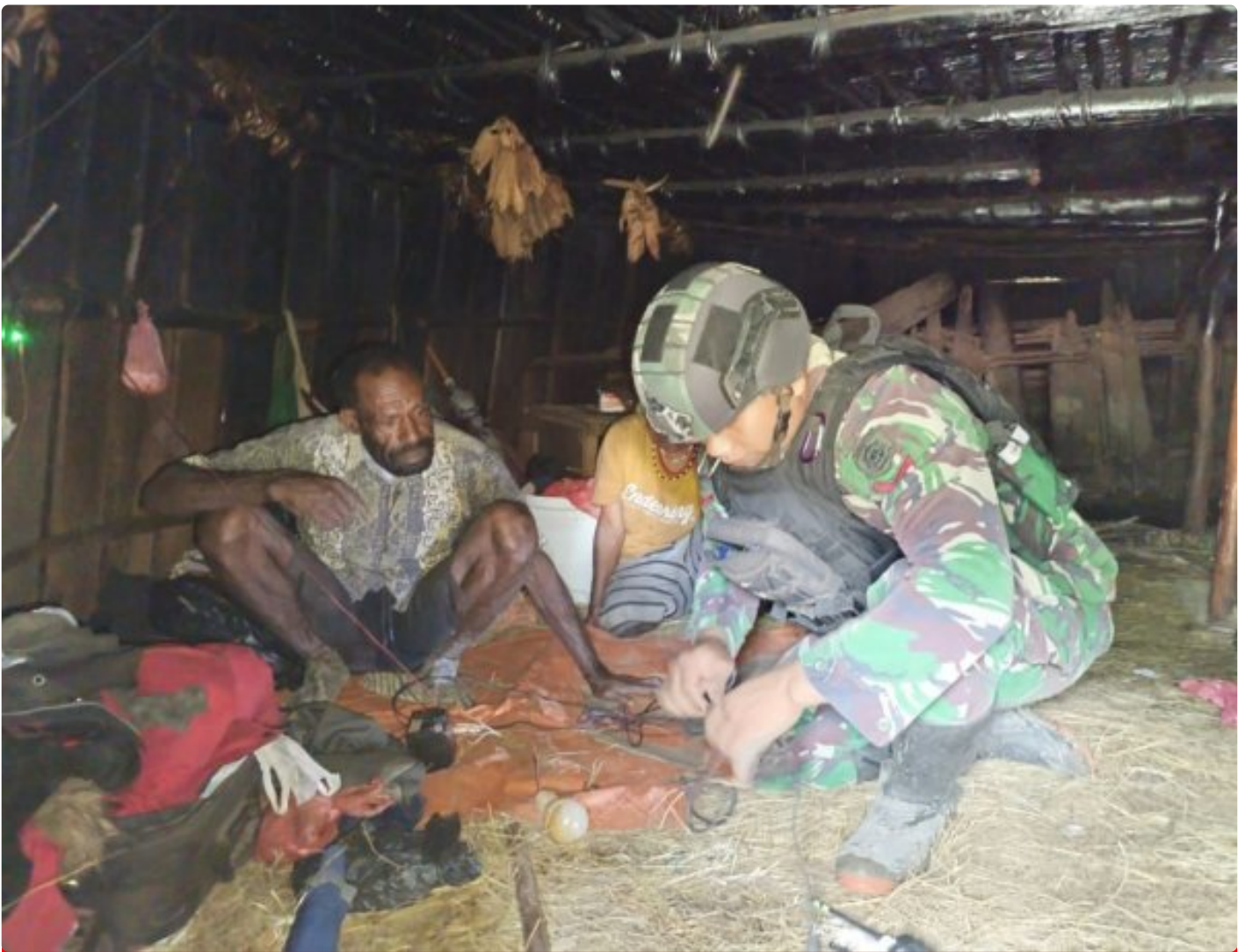
Foto: Satgas Yonif 323/BP TK Wuloni Memperbaiki Instalasi Listrik Dan Lampu Penerangan di Rumah Warga Kampung Wuloni, Distrik Ilaga Utara, Kabupaten Puncak, Papua, Sabtu (20/06/2024).
